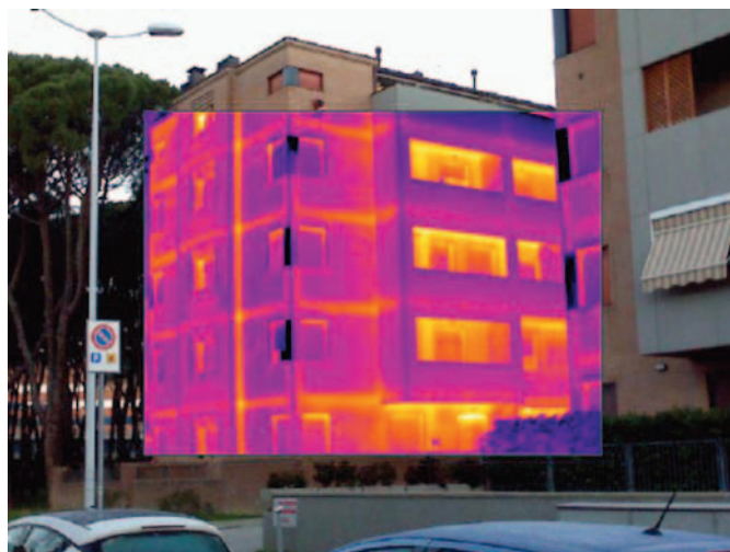
Arezzo, edilizia residenziale privata, 2008-2010
