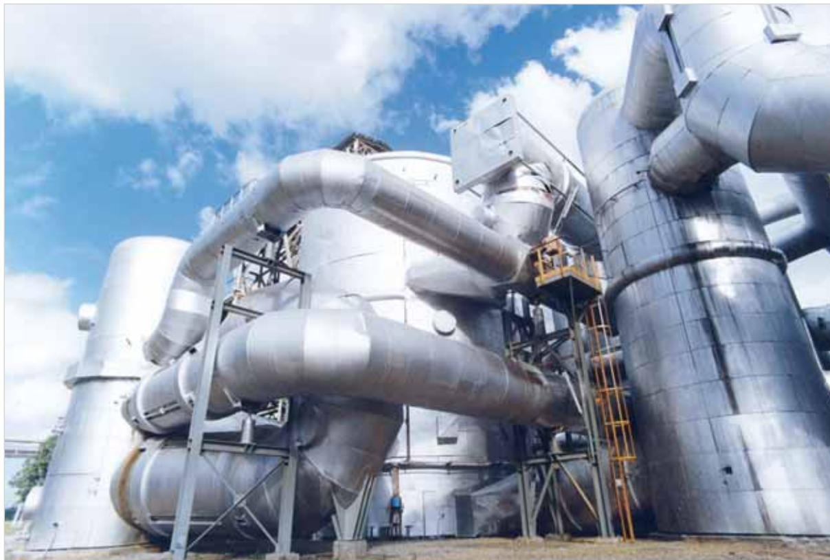
Impianto chimico, Scarlino (GR)
