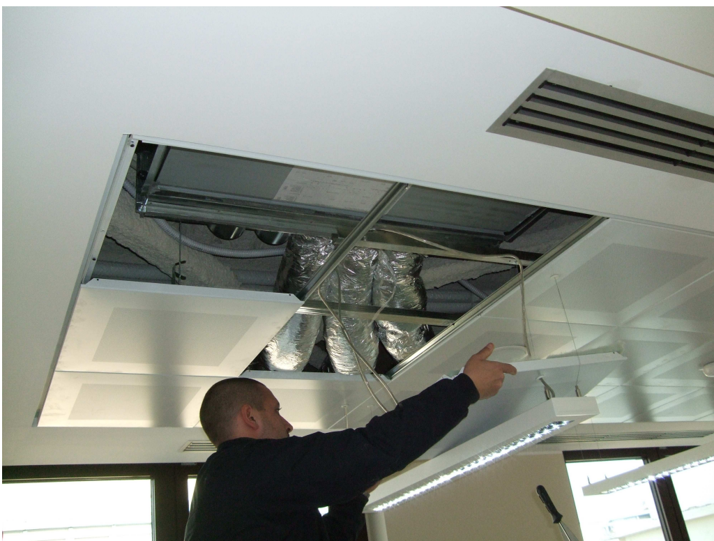
Figura 2. Verifica in fase di installazione (Habitech)
