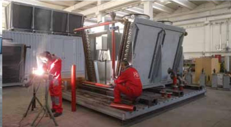
> realizzazione piping dissipatore di emergenza
