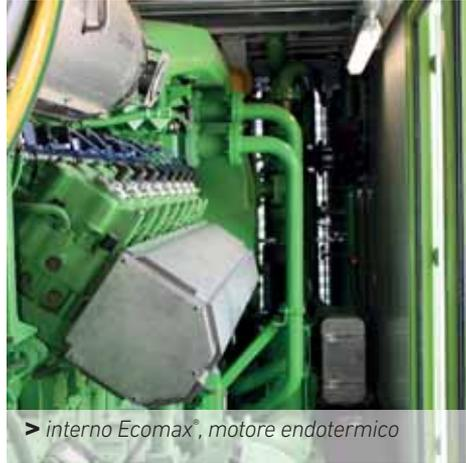
> interno Ecomax®, motore endotermico
